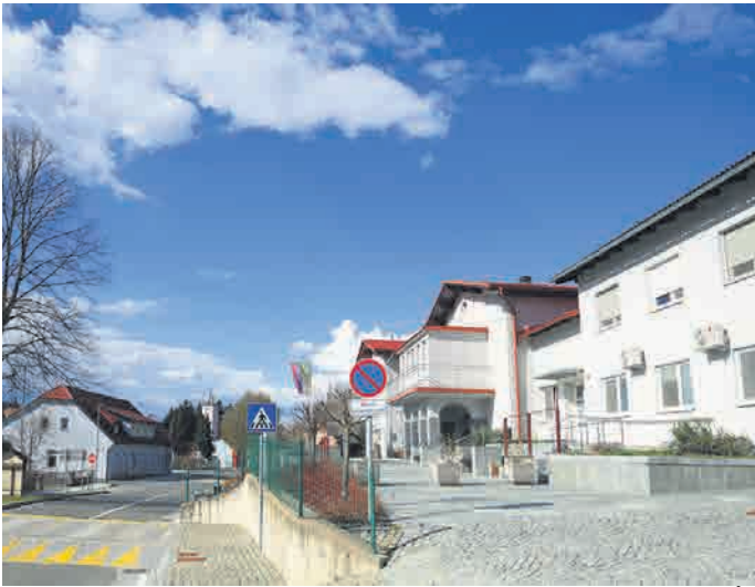
Občina Zavrč je v centru pridobila novo transformatorsko postajo s kapaciteto 1.000 kW.
