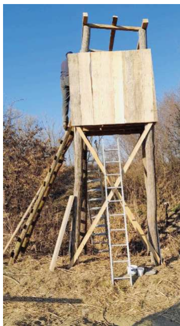
Lovska preža v izgradnji. Foto: arhiv društva
