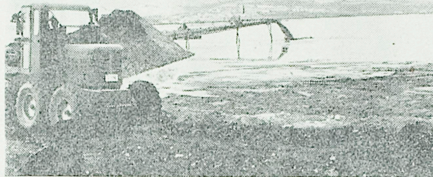
Ogromen buldozer planira navoženo zemljo na začetku nasipa čez Skočjanski zaliv pri Izolanskih vratih, v ozadju pa cevovod bruha zmes vode in zemlje za nasip. Bager »Peter Klepec« požira dno v bodočem pristanišču in material tlači po ceveh na področje, kjer bodo že v bližnji prihodnosti zelene kmetijske površine in nasadi zgodnjih vrtnin
