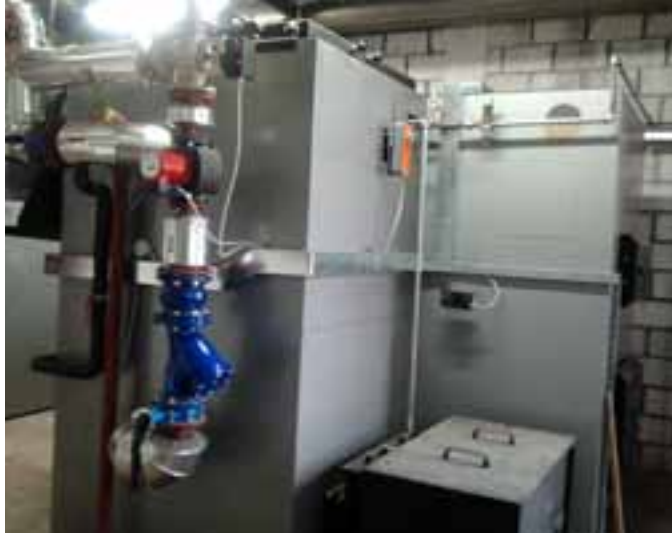
Razdelilnik toplote v kotlovnici
