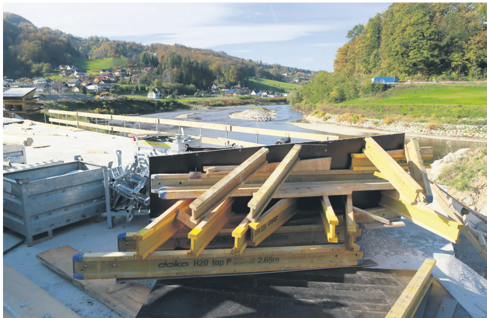
Gradbena dela na prvem mostu čez Lahomnico in pogled na Savinjo, čez katero bo zgrajen nov 110 metrov dolg most (približno na mestu, kjer je viden moder tovornjak na drugi strani Savinje, na cesti Laško-Rimske Toplice).
