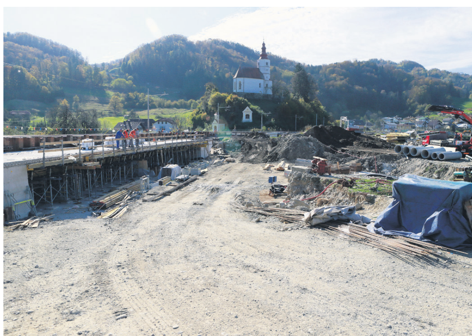
Nov podvoz pod železniško progo Laško-Rimske Toplice bo izboljšal pretočnost prometa na tem območju.
