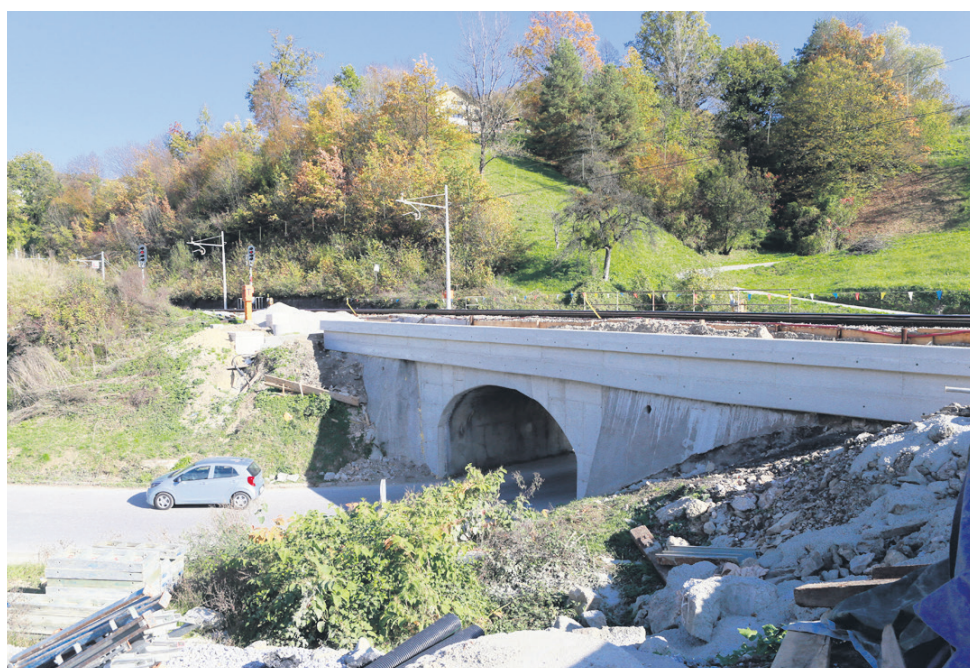
... sedanji podvoz se bo z novo ureditvijo spremenil v podhod, namenjen pešcem in kolesarjem.
