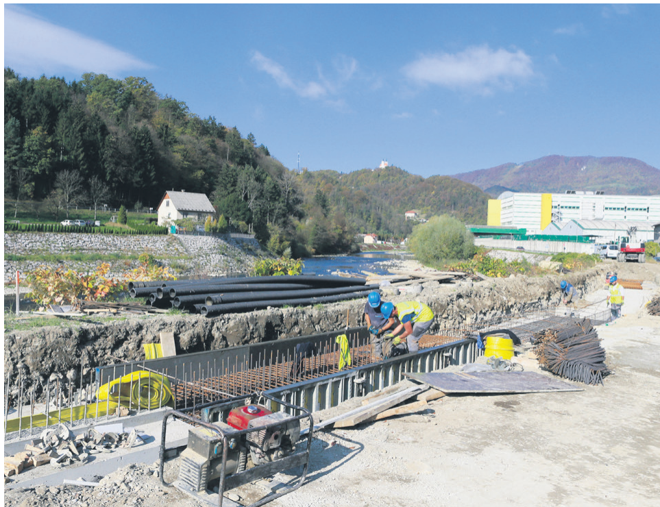
Gradnja 250 metrov dolgega protipoplavnega zidu ob Savinji
