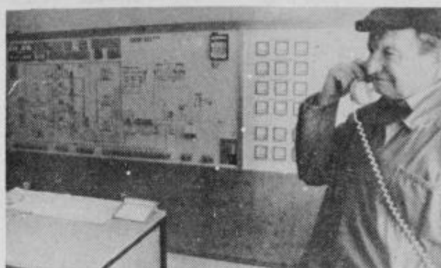
Pogled na srce vodarne v Medlogu.
