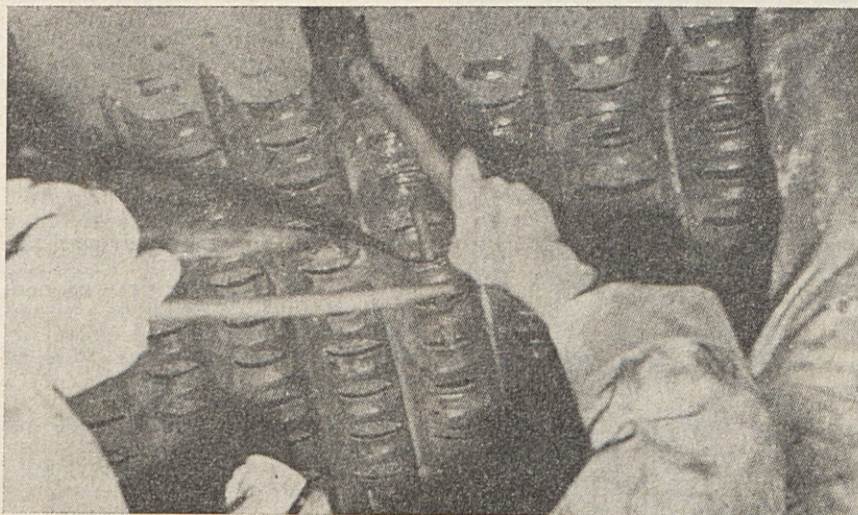
Montaža rebraste pločevine
