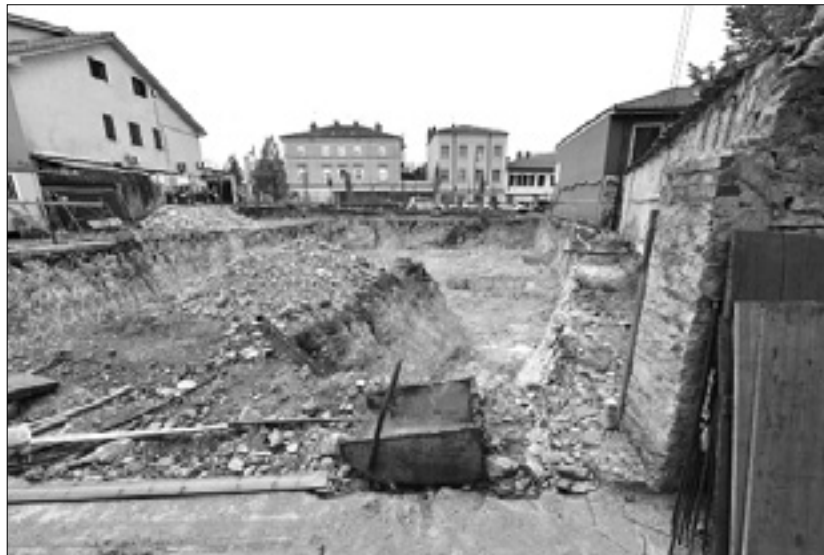
Gradbišče v središču Opčin
