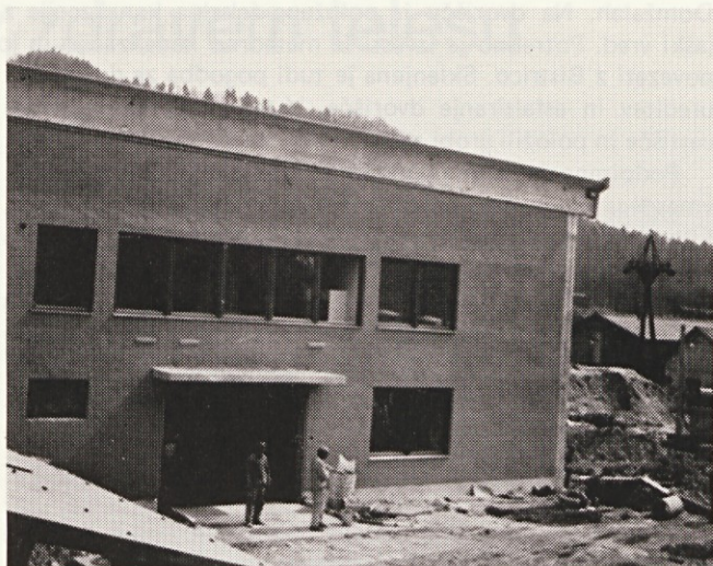
Zapadna fasada z avtomatskimi vrati. V tem delu objekta so vsi obratni prostori in laboratoriji
