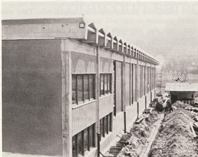
Južna fasada oplemenitilnice z meteorno kanalizacijo in skladiščem vnetljivih tekočin
