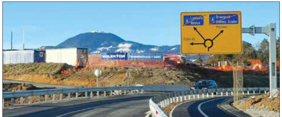
Za že zgrajene dele ceste pri Gaberkah DARS pridobiva uporabno dovoljenje. (Foto: Knmedia.net)
