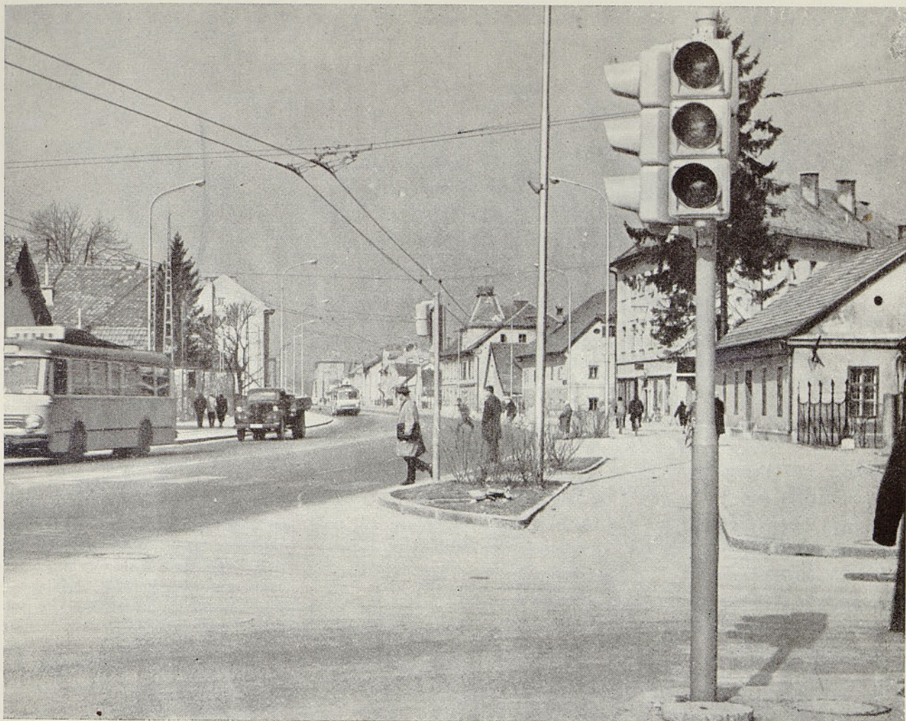
Med drugim bodo tudi na križišču Celovške ceste s Tržno in Gasilske ulice semaforji »Iskre« usmerjali promet
