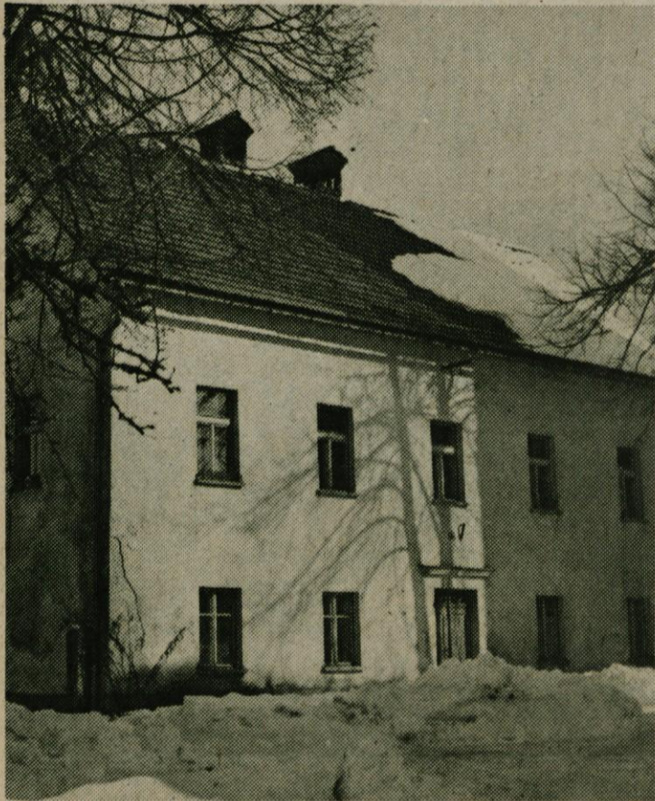
Gradnja nove šole v Hotedršici
