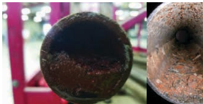
Slika 1 : Odpadanje rje in delcev iz stare črne cevi v sistemu cevovodov
