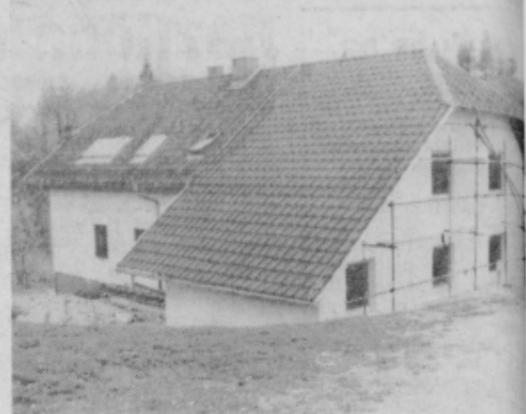
Obnovljen in dozidan Dom borcev na Dobrovljah.
