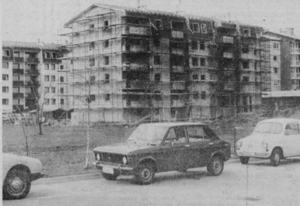
V Soseski V. v Žalcu gradijo stanovanjski blok z 58 stanovanji.
