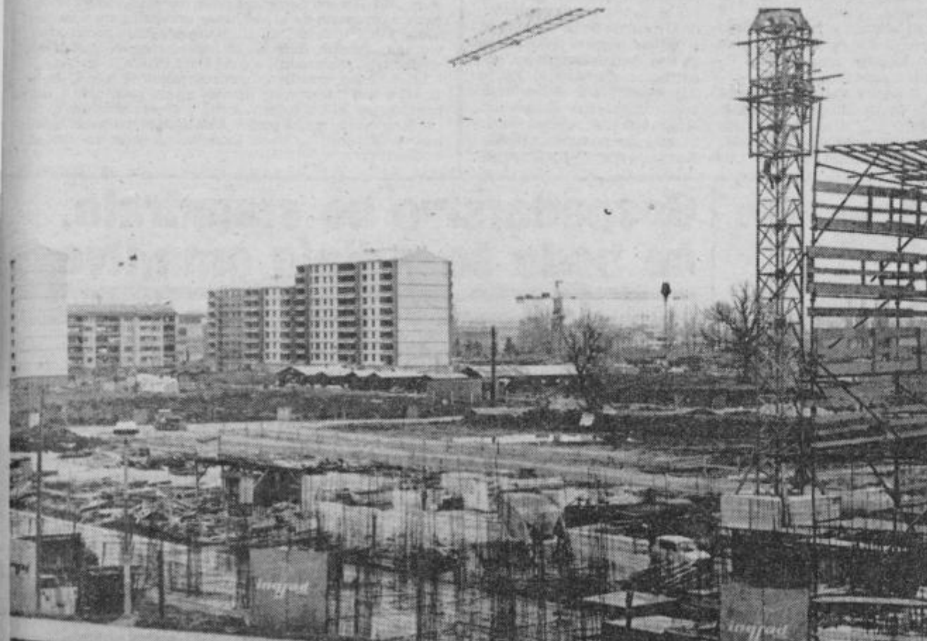
Največje gradbišče v celjski občini je na Hudinji, kjer naj bi že v pomladanskih mesecih pridobili 224 stanovanj.
