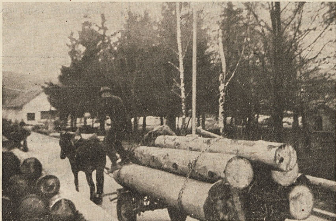
Voznik pelje les na skladišče LIP v Ribnici
