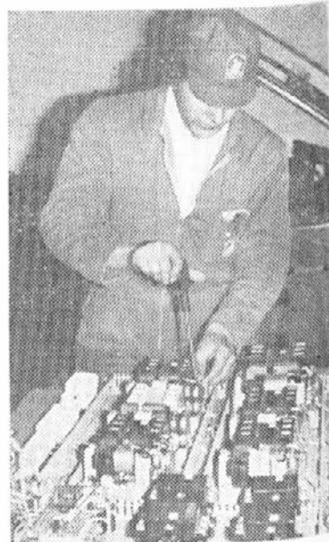
Elektrikar za zahtevna dela
