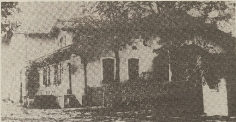
Pogled na stavbo mestnega podjetja za plin ob koncu 19. stoletja
