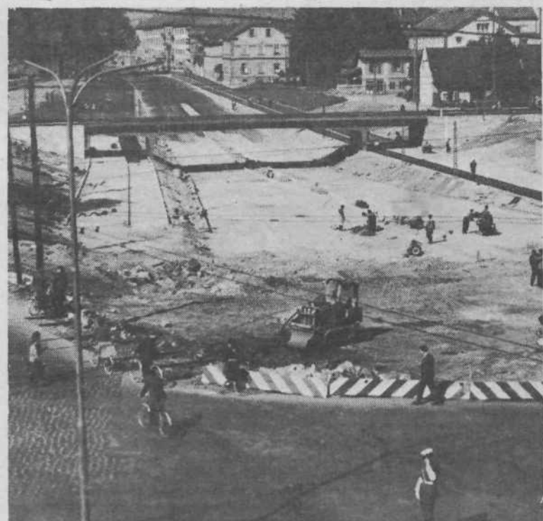
Podvoz na Celovski cesti med gradnjo.
