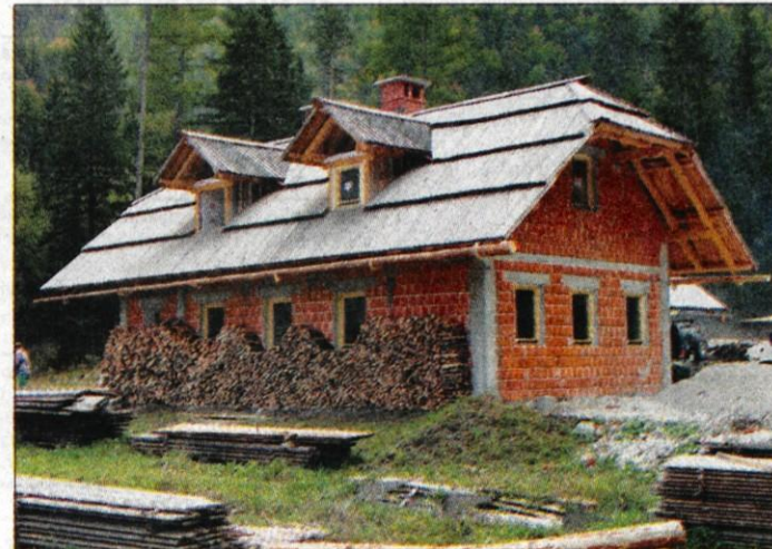
Dom gradijo s prostovoljnim delom.
