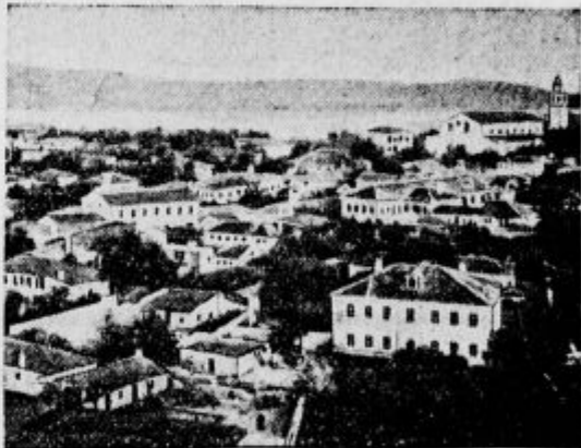
Pogled na Skader
