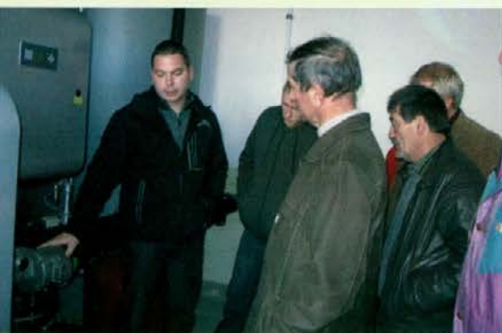
Škratkovi se ogrevajo s pomočjo te sodobne kotlovnice na sekance
