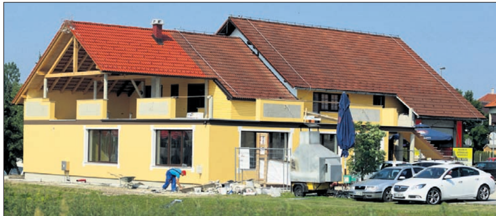
Gradbeništvo Kelenc je bilo izvajalec del tudi pri razširitvi znanega gostinskega objekta Raj s teraso na Osojnikovi cesti na Ptuj. Foto: Črtomir Goznic
