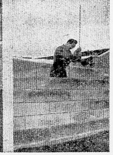
Neka angleška gradbena tvrdka je patentirala nov izum. Gre za posebno vrsto opeke, ki se nataka na jeklene palice, tako da ni treba zidati več z malto. Taka gradnja je veliko hitrejša, razen tega pa je mogoče zgradbo s takim zidom porušiti in prestaviti brez težav. Enodružinska hiša se more postaviti s to opeko v 24 urah.
