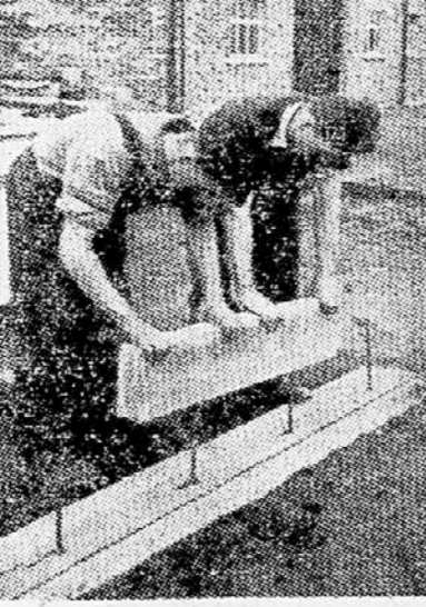
Neka angleška gradbena tvrdka je patentirala nov izum. Gre za posebno vrsto opeke, ki se nataka na jeklene palice, tako da ni treba zidati več z malto. Taka gradnja je veliko hitrejša, razen tega pa je mogoče zgradbo s takim zidom porušiti in prestaviti brez težav. Enodružinska hiša se more postaviti s to opeko v 24 urah.
