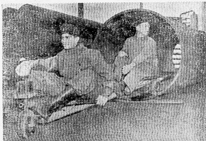
Delavci, ki kontrolirajo cevovode v Stuttgartu v Nemčiji, nimajo več težkega dela, ker jim ni treba več plezati po vseh štirih več kilometrov daleč po cevih. Omisli si si posebne vozčke, s katerimi se »sankajo« skozi cevovode in jih tako hitreje pregledajo, delo pa jim je celo v zabavo.
