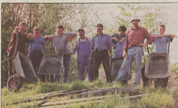
Udarniki so na gradbišču preživeli praznik in še veliko popoldnevov, Kelemina tudi nekaj dni dopusta.
