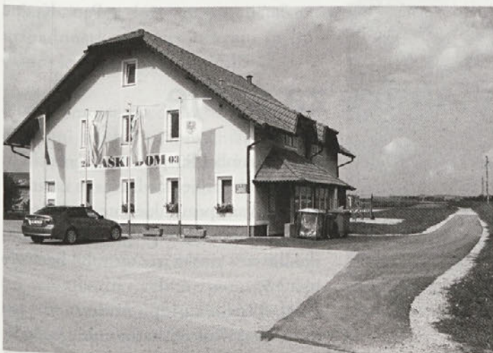
Nova pridobitev je tudi asfaltirani cestni odsek ob vaškem domu v dolžini 60 m.
