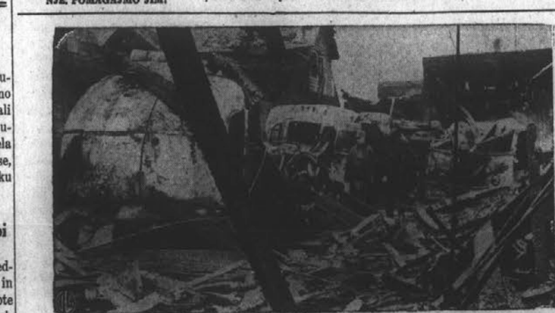
V neki garaži v North Tonawanda, N. Y. je bilo spravljenih 11 busov. Nastal je požar in slika nam kaže kaj je še ostalo od petih busov izmed enajstih, ki jih je zajel ogenj. Škoda je cenjena na $150,000.00.
