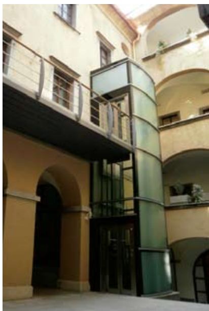
Dvigalo podjetja Otis lift, d. o. o.
