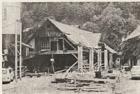
Podiranje, izgradnja in proizvodnja — vse je potekalo istočasno
