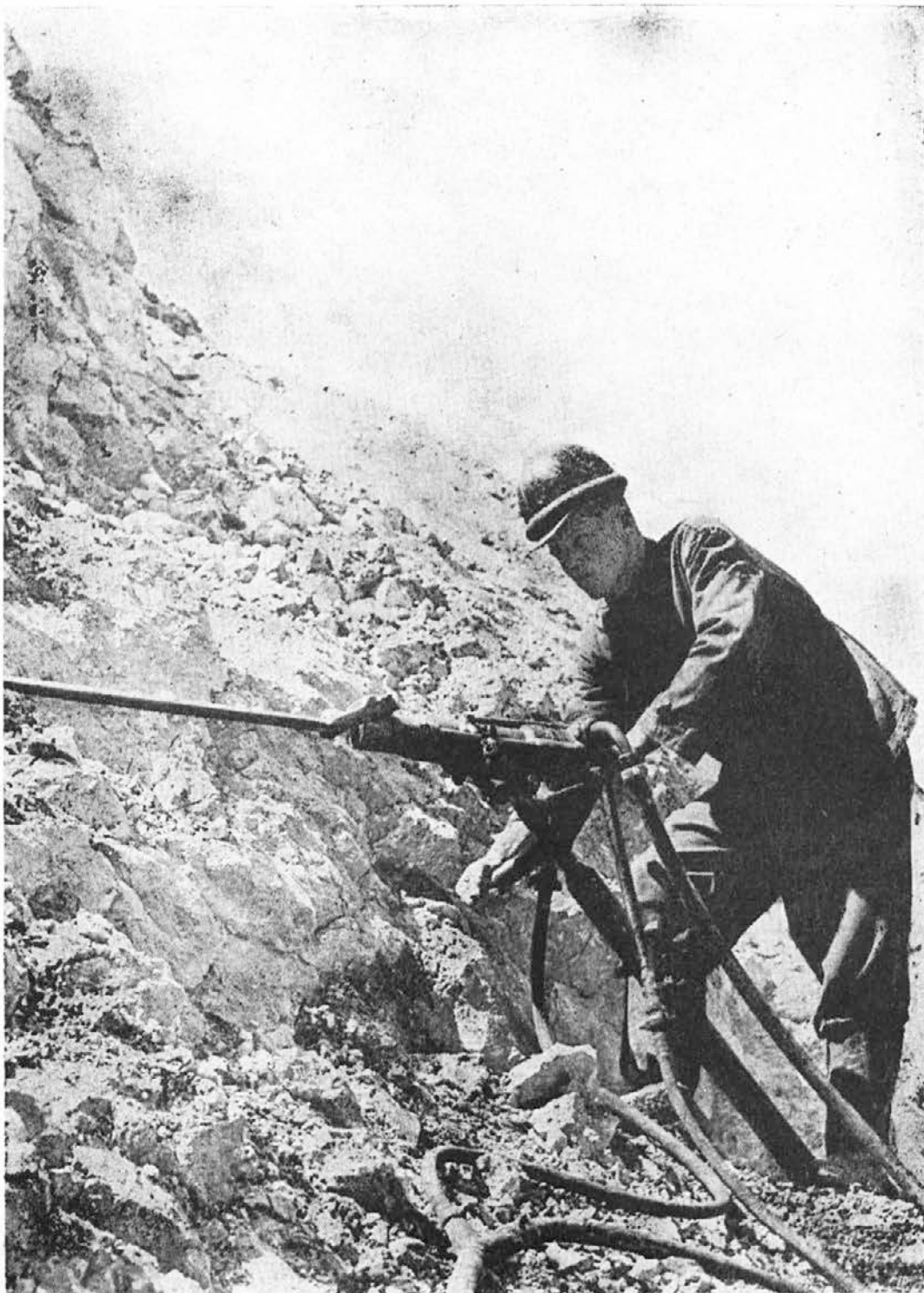
Preizkus pnevmatskega vrtnega kladiva RK-21 s podporno nogo
