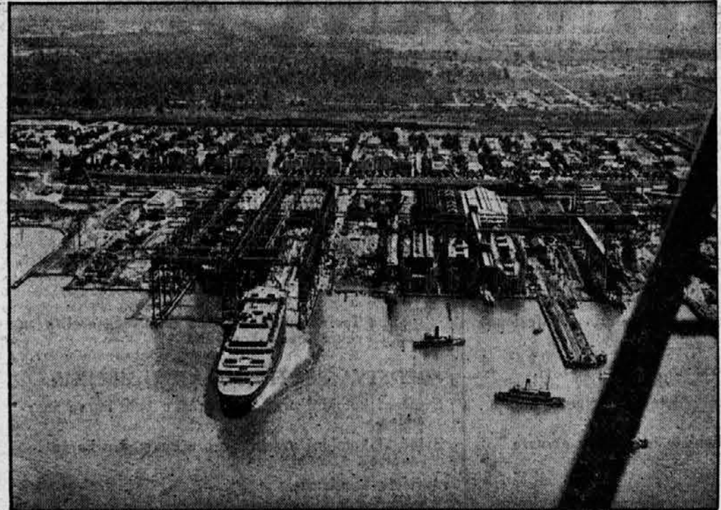
Pogled na sodobno urejeno ladjedelnico
