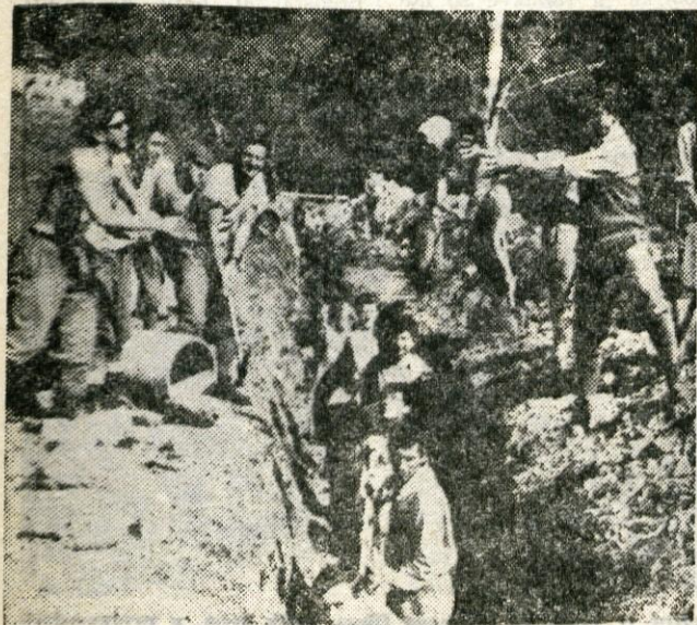
Vojaki kopljejo jarek, kamor delavci podjetja Vodovod iz Kranja polagajo vodovodne cevi profila 40
