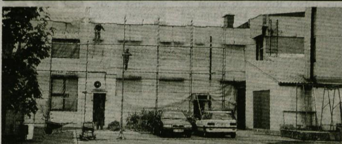
Počitnice so tudi priložnost za obnovo osnovnih šol, ki so v letošnjih počitniških mesecih doživele kar nekaj novosti. Fotografija prikazuje obnovo fasade na Osnovni šoli Rodica.
