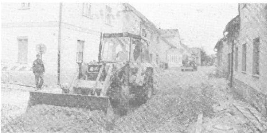
Cesta IV bo kmalu dobila asfaltno prevleko
