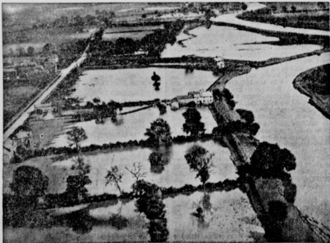
Velikanska povodeni v Yorkshire (Anglija). Voda stoji meter visoko in je škoda ogromna.
