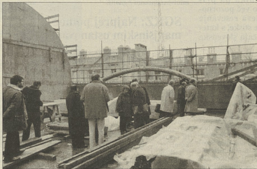
Obisk prostorov gledališča Verdi, kjer so obnovitvena dela v polnem teku
