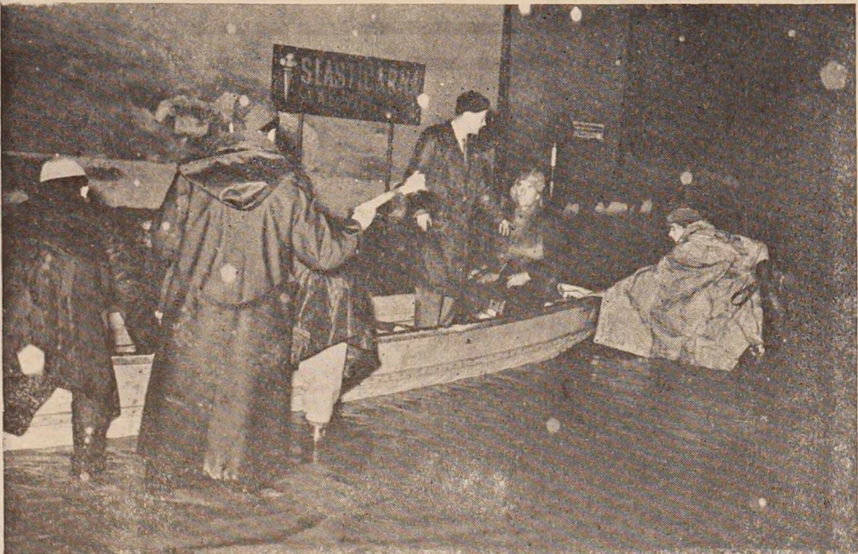
Zagrebske ulice so se spremenile v kalne potoke. Tudi s čolni se je bilo težko prebijati po njih. Kalne vode pa so povzročile ogromno škodo. Zato prihaja pomoč Zagrebčanom z vsega sveta.
