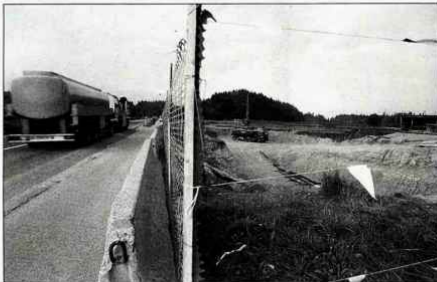
Na trasi načrtovane avtoceste od Peračice do Vrbe že opravljajo zemljskega dela in gradijo temelje nekaterih premostitvenih objektov. / Foto: Tina Dokl
