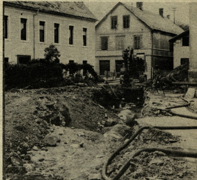
Izgradnja kolektorja v Petrovčah, ki bo povezoval Ruše, Arjo vas in Petrovče s centralno čistilno napravo, je v polnem teku. Dela izvaja NIVO Celje, hkrati z izgradnjo kolektorja pa bodo rekonstruirali tudi cesto skozi Petrovče.
