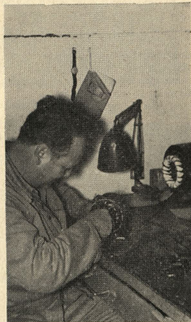
Tovariš Majcen Nande pri svojem vsakodnevnem delu — pre- vijanju električnih motorjev, ki so se pokvarili med obratova- njem
