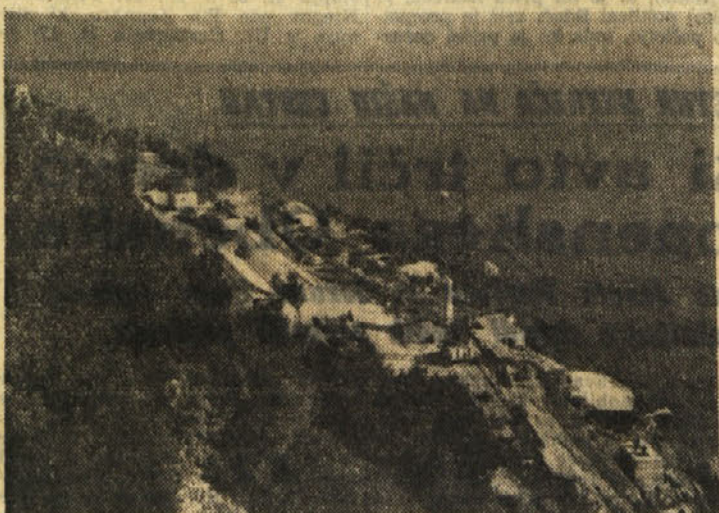
Začetek gradnje hotelske šole pri Brojniči
