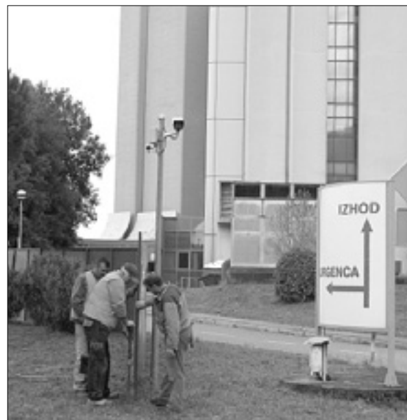
Delavci postavljajo gradbeno ograjo
