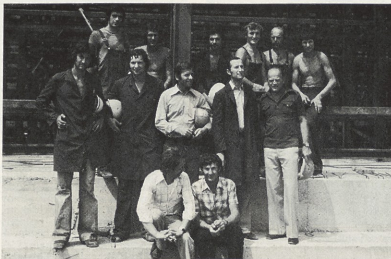
Skupina mariborske Metalne, ki je v dokaj kratkem času postavila ogrodje regalnega skladišča
