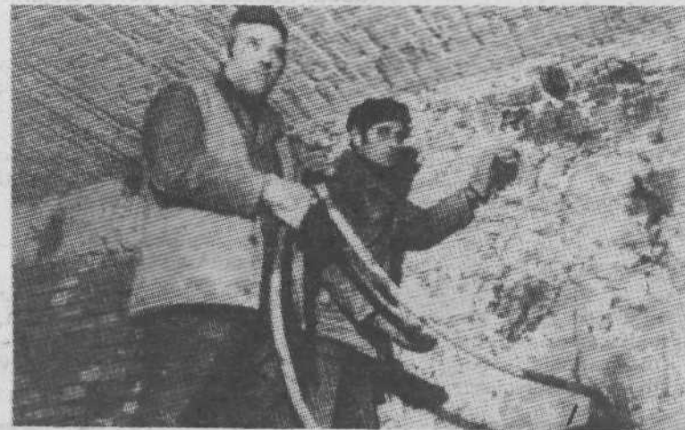
Prenovitev stanovanjske hiše Stari trg 6 – sodelovanje Tehnike in ZRMK. Posneli smo delavca ZRMK pri jačanju starih zidov s cementno suspenzijo, ki je sestavljena iz cementa, vode in opalske breče.
