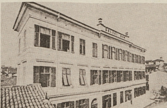
Šolski dom v Križni ulici takoj po otvoritvi konec prejšnjega stoletja
