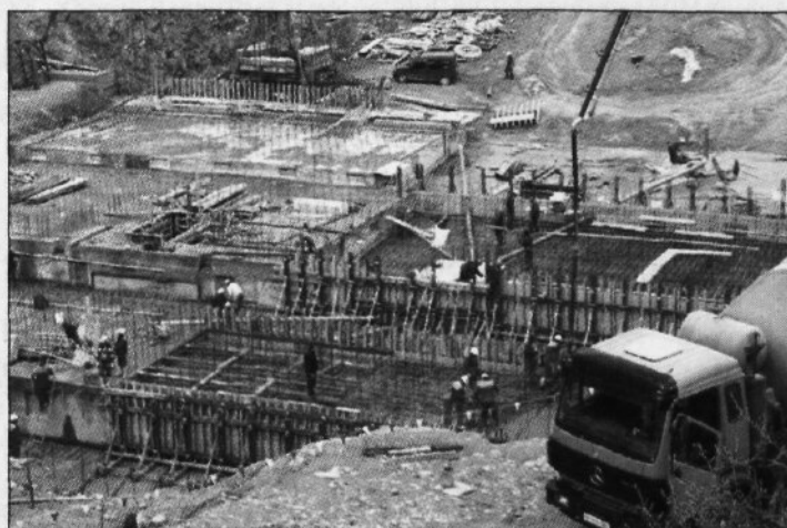
Pogled na dno gradbene jame z njenega vrha, 35 metrov nad njim.
