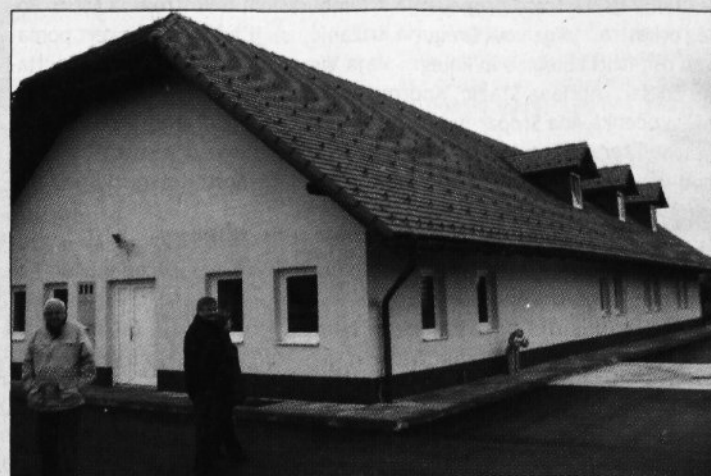
Čistilna naprava se nahaja ob vhodu v mesto nasproti bencinskega servisa.
