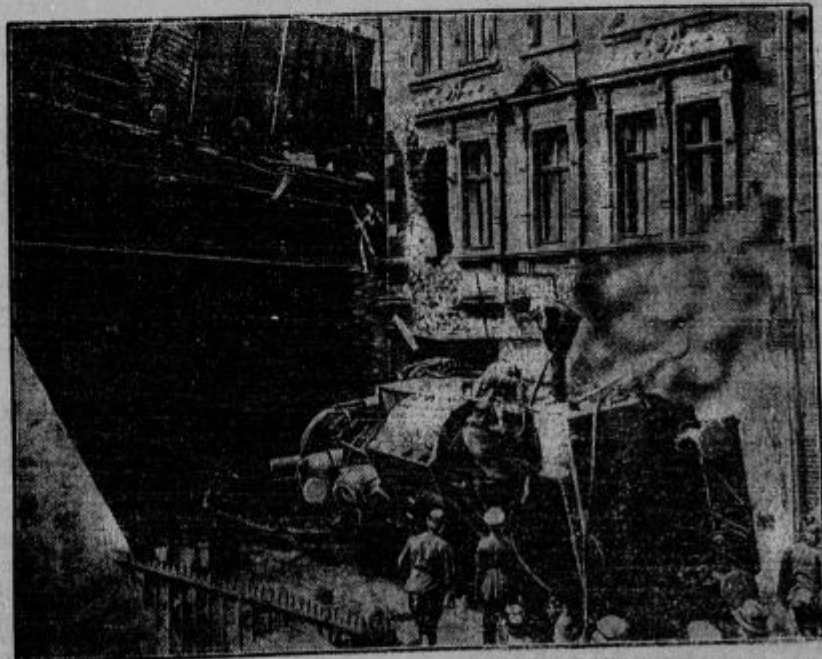
Lokomotiva padla na prometno cesto. V Essenu je nad železniškim podvozom iztrčila ranžirna lokomotiva, prelomila železno ograjo in padla na cesto. Strojevodja in kurjač sta bila takoj mrtva, neki deček je bil pa od sopare tako opečen, da so ga morali prepeljati v bolnišnico.
