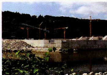
Hydroelektrarna Blanca v izgradnji
