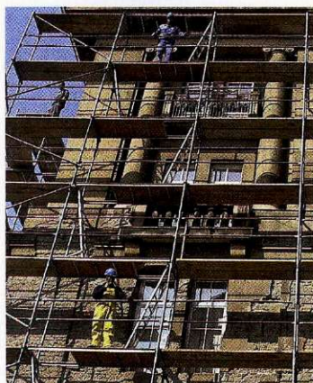
V gradbeništvu zaposlujejo tujce.
