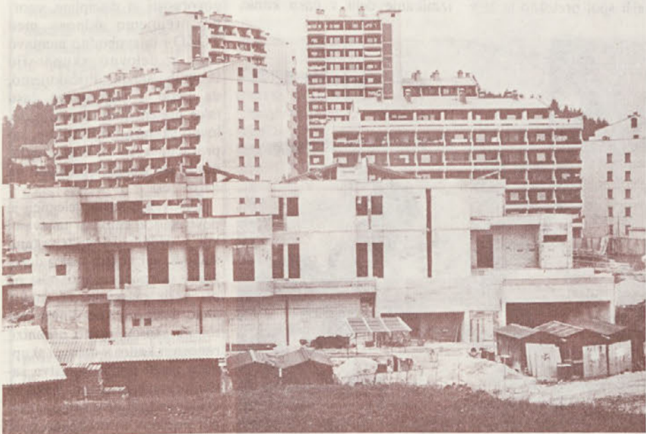
Izgradnja blagovnice Bevče v Velenju
